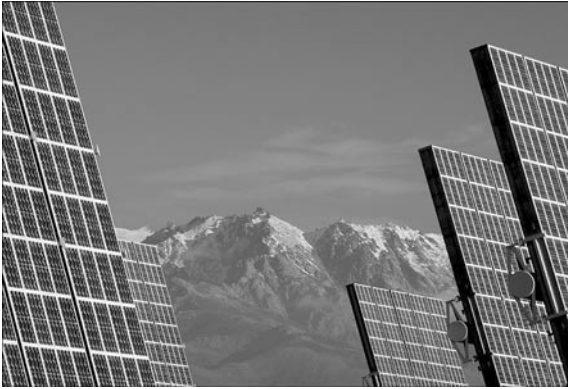
Alta concentración de módulos fotovoltaicos en el oeste de España.
