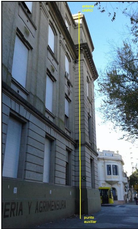
Figura 4: Punto auxiliar localizado directamente bajo la antena de la EP UNRO.
