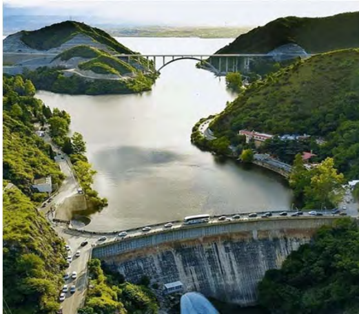
Dique Lago San Roque, VCP
