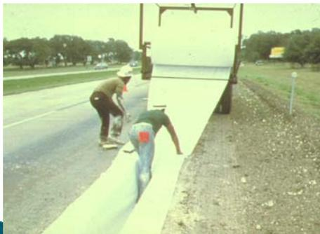
Geotextil de filtro s/ la trinchera
