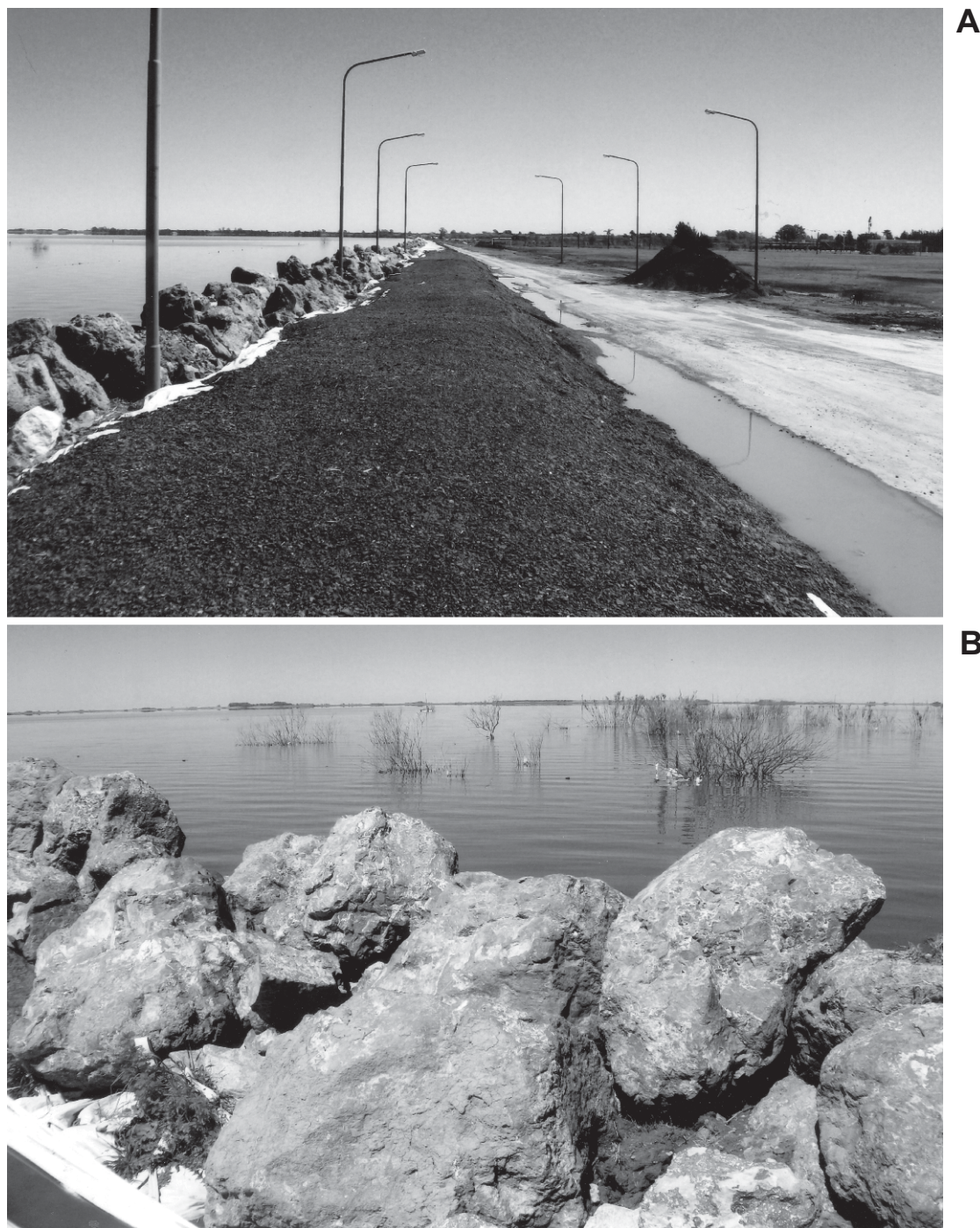
Figura 6. Defensas sobre la Ruta Provincial 90 descritas en el texto. A: vista panorámica general. B: detalle de la roca utilizada. Registro fotográfico año 2017.
