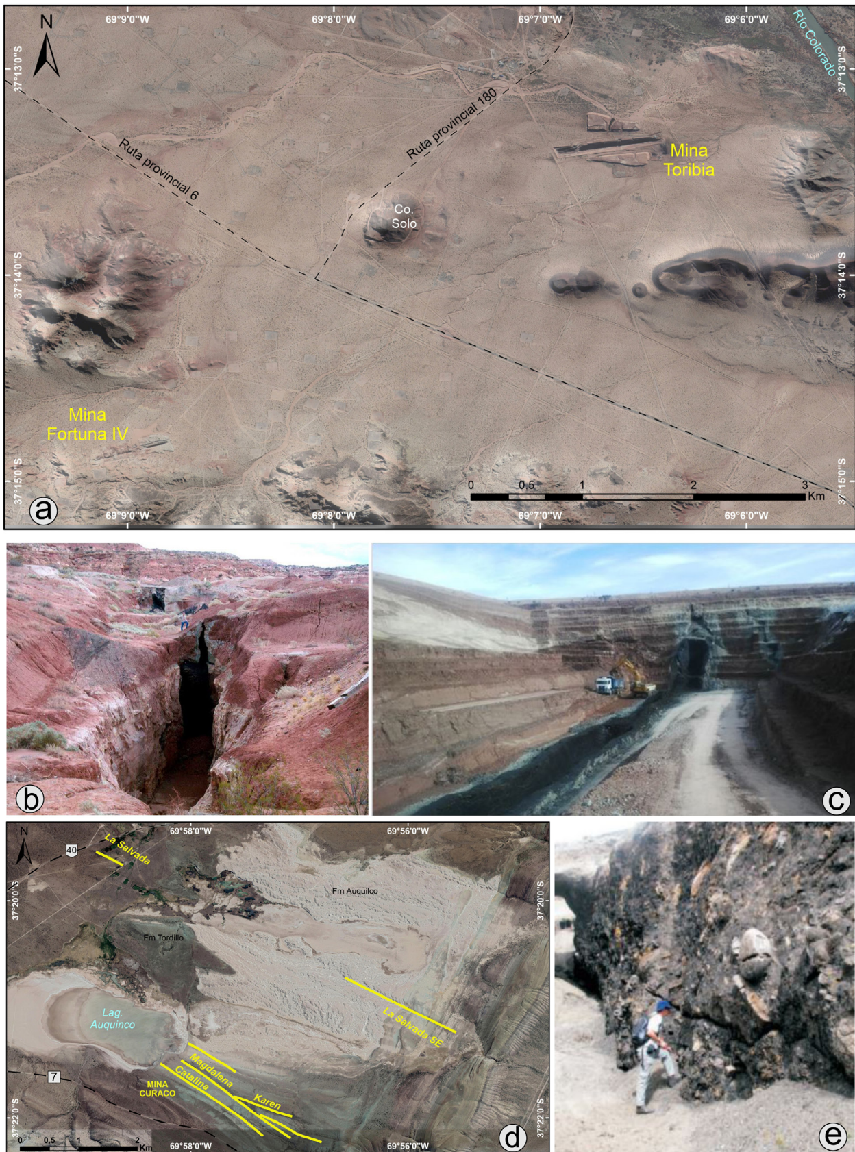
Figura 41. a) Ubicación de los depósitos Toribia y Fortuna IV. Las locaciones que se observan corresponden al Yacimiento Puesto Hernández. b) Mina Fortuna IV: rajo realizado sobre veta de asfaltita alojada en sedimentos del Grupo Neuquén. c) Mina Toribia: labores extractivas. d) Ubicación de las vetas de asfaltita en el área de la mina Curaco. e) Mina Curaco: detalle del depósito (foto Cobbold et al. 2011)
