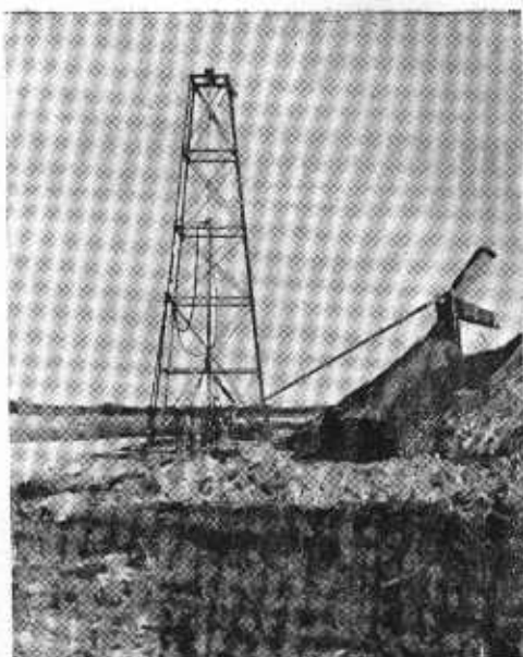
Fig. 2. — Vista parcial de la torre destinada a la extracción de la arena subterránea. Villa Recondo. A la izquierda el río Matanzas. Foto. C. Rusconi, julio, 1933.
