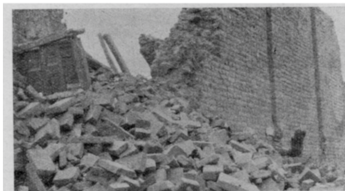
Fig. 74. — Paredones de la iglesia del barrio de Concepción. Ciudad de San Juan. Enero 16. (Fotografía Ronchietto)
