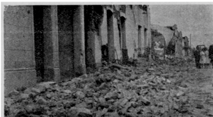
Fig. 37. — Edificación de la parte sud de la ciudad de San Juan, que a pesar de ser de adobe ha sufrido poco los efectos del sismo. Enero 16. (Fotografía Ronchietto)
