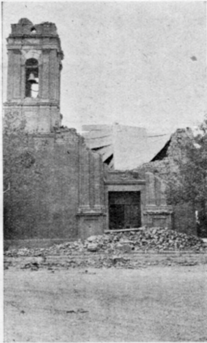
Fig. 59. — Templo departamental de Santa Lucía, frente a la plaza de su nombre. La torre es de ladrillo y el resto del edificio de adobe con techo de chapas de hierro galvanizado. (Fotografía Castellanos)
