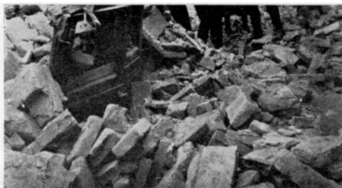
Fig. 31. — Escombros en una calle de la zona sud de la ciudad de San Juan. 16 de enero. (Fotografía Ronchietto)
