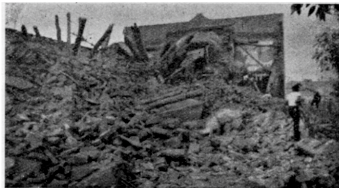
Fig. 44. — Escombros pertenecientes a varios edificios de la zona central de San Juan. Enero 16. (Fotografía Ronchietto)
