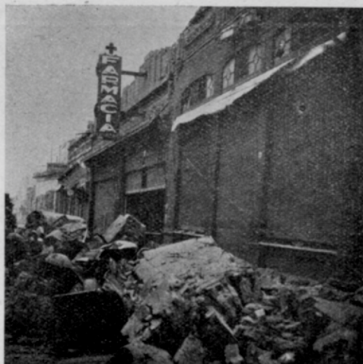
Fig. 40. — Calle General Acha entre Santa Fe y Bartolomé Mitre. La calzada cubierta de escombros. Enero 16. (Fotografía Rusconi)
