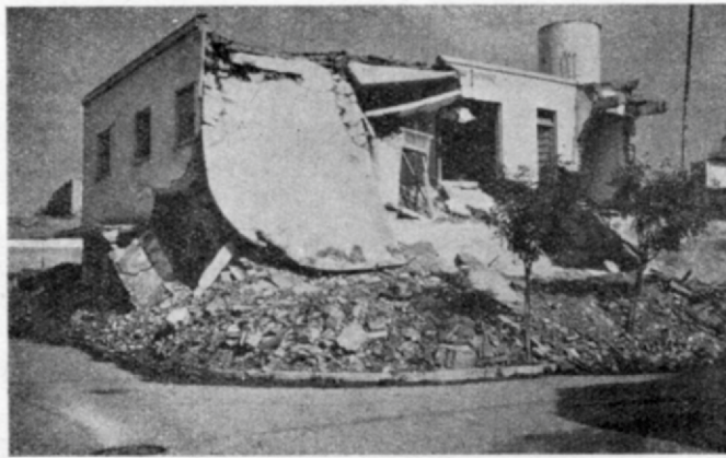
Fig. 14. — Mercadito al lado del Consulado Uruguayo. Edificio de ladrillo, techo de loza de hormigón armado. Calle Rioja esq. Laprida. (Fotografía Castellanos)
