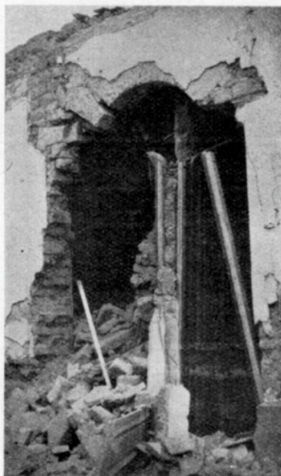
Fig. 50. — Antigua puerta dividida en dos por un tabique. Casa de la zona central de la ciudad de San Juan
