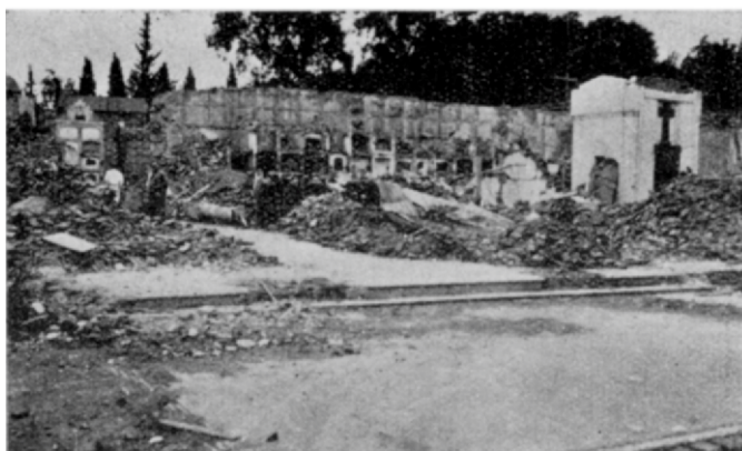
Fig. 83. — Cementerio. Sección de los nichos. Los ataúdes, por el movimiento, voltearon el tabique y saltaron afuera. (Fotografía Castellanos)
