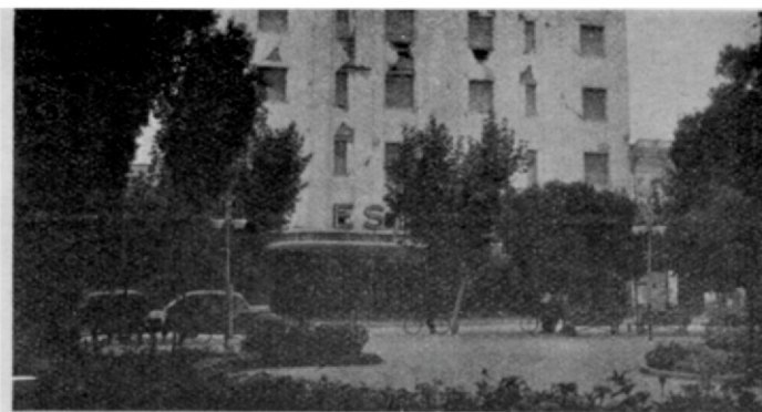
Fig. 41. — Teatro Estornell. El edificio más elevado de la ciudad de San Juan. Presenta algunas grietas en su fachada. Enero 16. (Fotografía Ronchietto)
