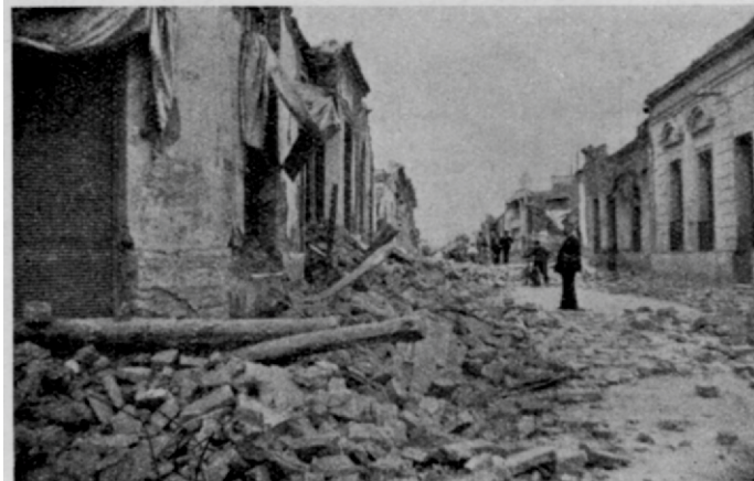
Fig. 36. — Aspecto de la calle Rivadavia después del sismo
