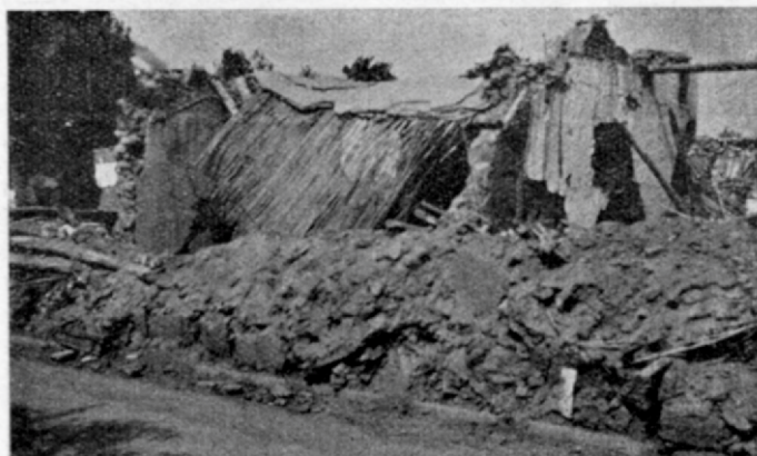
Fig. 12. — Casas de adobe que miran al E.; techo de cañizo y barro con paja en varias capas. Fábrica de Cerveza y Maltería Río de la Plata, de B. B. Zarich. Calle Mendoza, entre 25 de Mayo y Pedro Echagüe. (Fotografía Castellanos)
