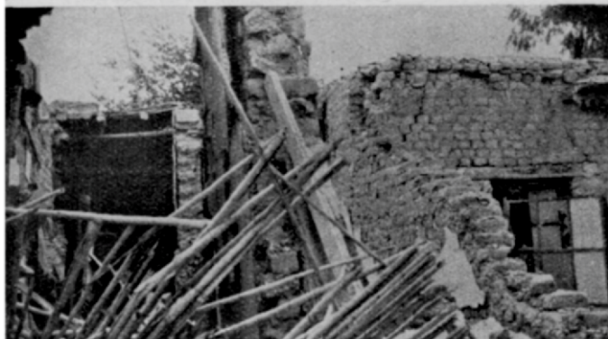
Fig. 42. — Tipo de construcción de adobe de la zona sud de la ciudad de San Juan, donde han sido menos evidentes los efectos del sismo. Enero 16. (Fotografía Ronchietto)
