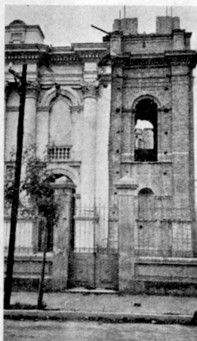
Fig. 80. — Templo de Santo Domingo. La parte sin revoque es la reconstruida, derrumbada en el terremoto del 27 de octubre de 1894. (Fotografía Castellanos)
