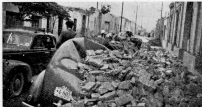
Fig. 34. — Calzada cubierta de escombros en la parte central de la ciudad de San Juan, 16 de enero. (Fotografía Ronchietto)
