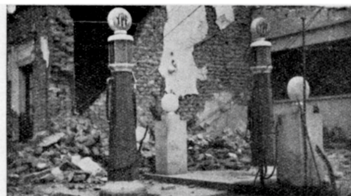
Fig. 35. — Edificio de adobe de un surtidor de nafta de Y. P. F. Enero 16. (Fotografía Ronchietto)
