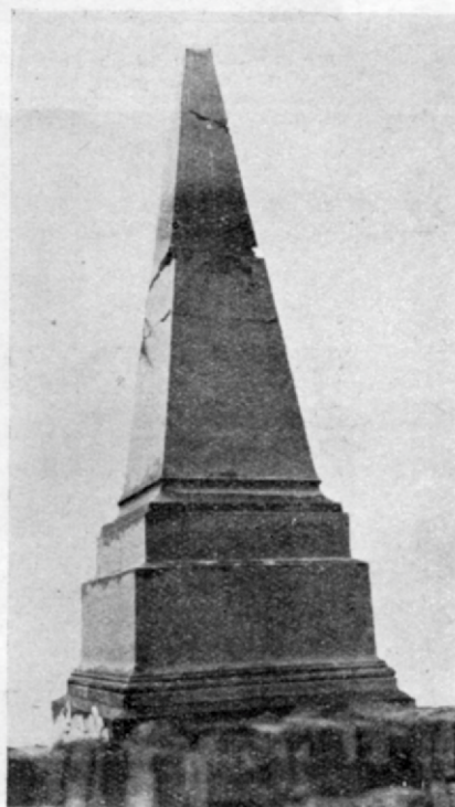
Fig. 89. — Pirámide de ladrillo, en 3ª norma. Cementerio de San Juan. (Fotografía Castellanos)
