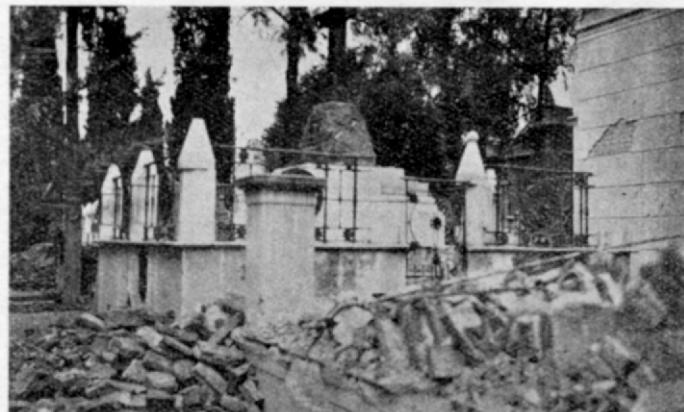
Fig. 84. — Panteón del cementerio de San Juan, que muestra grietas y desplazamientos de los pilares. (Fotografía Castellanos)
