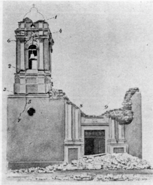
Fig. 60. — Templo departamental de Santa Lucía. Se indican los diferentes tipos de grietas
