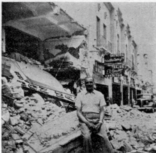
Fig. 30. — Calle Rivadavia. En primer plano el edificio del Bon Marché. Hay varios autos sepultados en la calzada. Enero 16. (Fotografía Rusconi)
