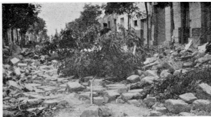
Fig. 27. — Acumulamiento de escombros en la calzada de una calle arbolada. Ciudad de San Juan. 16 de enero de 1944. (Fotografía Ronchietto)
