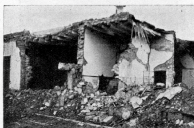
Fig. 49. — Casas que miran al E., pertenecientes al molino Delara. Los frentes están derrumbados. Calle General Acha entre 25 de Mayo y Chile. Techos de vigas de madera, cañizo y barro con paja. (Fotografía Castellanos)
