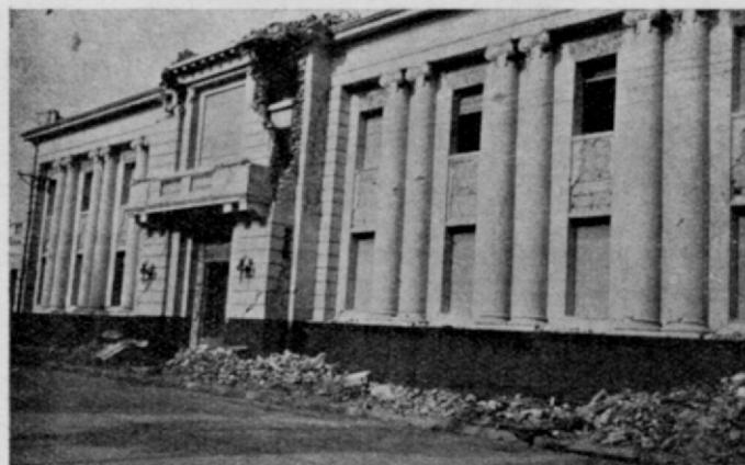
Fig. 61. — Palacio Municipal, frente a la plaza Aberastain. Calles Mitre y Caseros. Edificio de ladrillo. Derrumbe de las cornisas. Gran grieta vertical y otras conjugadas con inclinación de 45°. (Fotografía Castellanos)
