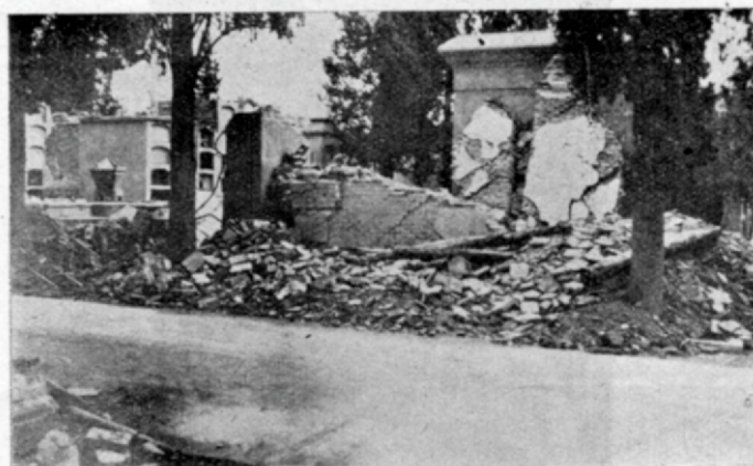
Fig. 86. — Cementerio de la ciudad de San Juan. Se observan los efectos del terremoto en los panteones. (Fotografía Castellanos)
