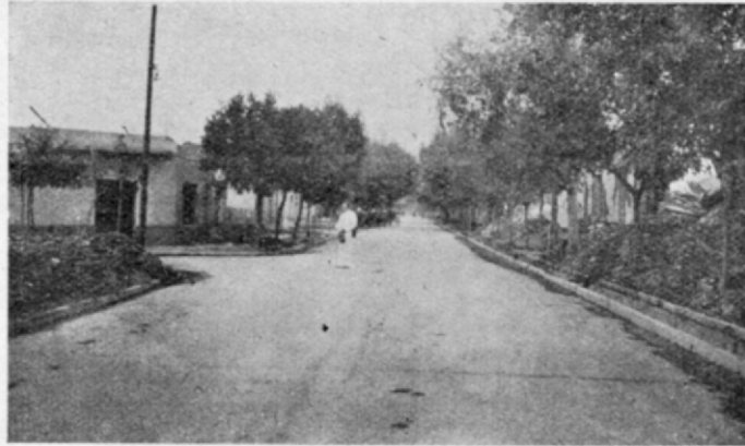
Fig. 28. — Casas de la Avda. 25 de Mayo esquina Rioja. Calle estrecha y arbolada. (Fotografía Castellanos)
