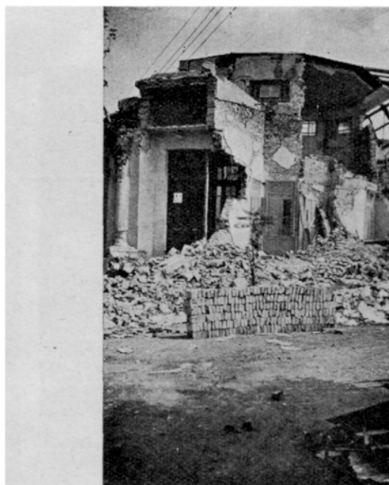
Fig. 24. — Biblioteca San Martín de Albardón. Edificación de ladrillo y techo de chapas de hierro galvanizado. (Fotografía Castellanos)
