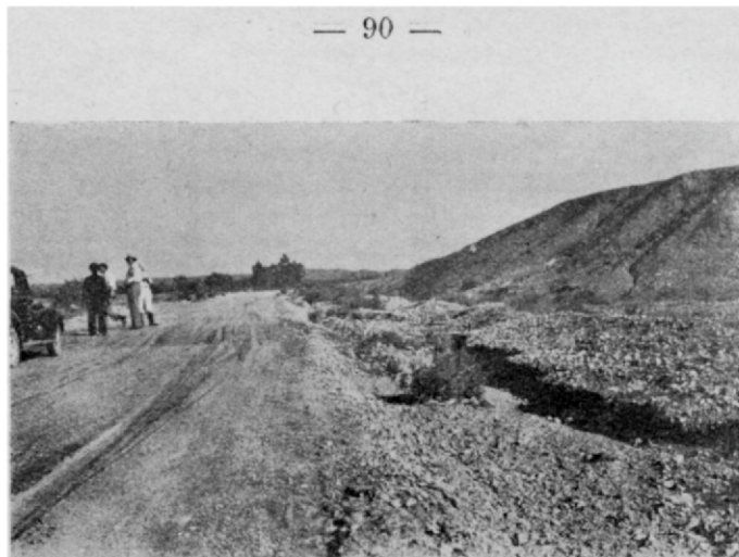
Fig. 18. — Grietas a 4 kilómetros al S. de los Baños de La Laja. Estado de las mismas 25 días después de producido el terremoto; se aprecia sólo el desnivel en el camino. (Fotografía Rubíes)
