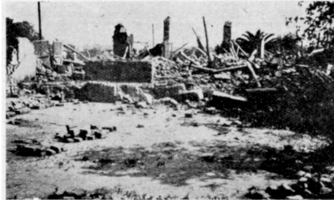
Fig. 43. — Grupo de casas que miran al W., cuyos muros han quedado en forma de agujas. Calle Tucumán entre Chile y Benavidez. (Fotografía Castellanos)
