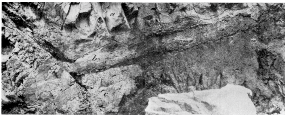
Fig. 107. — Camino de San Juan a Calingasta. Cerro Blanco. En la parte superior la colada de dacita (a), abajo areniscas del plioceno medio (c), entre ambas una capa de bombas volcánicas (b). (Fotografía Castellanos)
