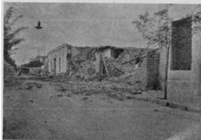
Fig. 45. — Casas de adobe derrumbadas. Ciudad de San Juan
