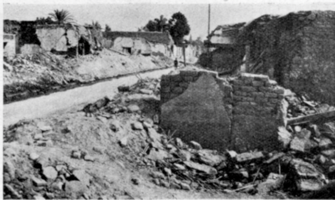
Fig. 52. — Grupo de casas de adobe derrumbadas. Calles 25 de Mayo y España. (Fotografía Rubíes)
