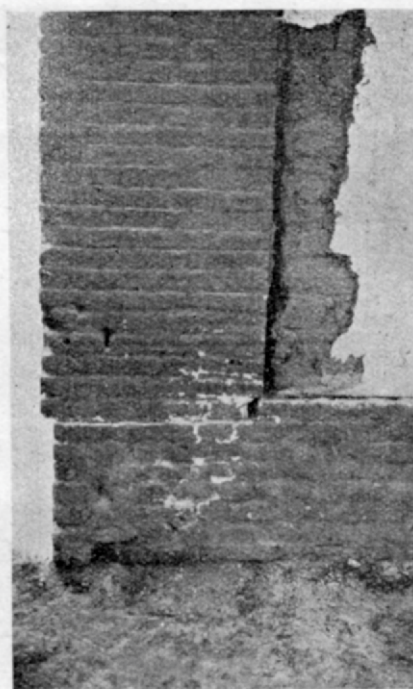
Fig. 115. — Pilar del portón de entrada de la bodega de Graffigna, mostrando un rechazo al S.W. Ullún. (Fotografía Castellanos)
