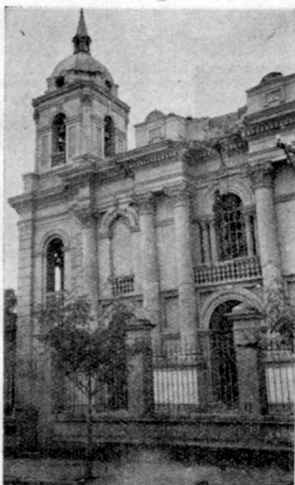
Fig. 79. — Templo de Santo Domingo, calle Entre Ríos (E. a W.), esq. Rawson. Grieta vertical en la parte superior de las aberturas del campanario y de la ventana central y grietas de inclinación de 45° en las ventanas simuladas. Parte de las cornisas derrumbadas. (Fotografía Castellanos)
