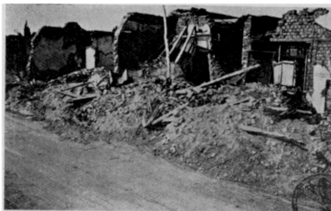
Fig. 46. — Serie de casas de adobe cuyos frentes que miran al E. se han derrumbado. Calle Tucumán (N. a S.), entre 25 de Mayo y Chile. (Fotografía Castellanos)
