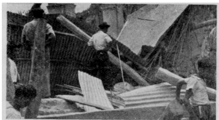
Fig. 76. — Techo derrumbado de la iglesia del barrio de Concepción. Ciudad de San Juan, Enero 16. (Fotografía Ronchietto)
