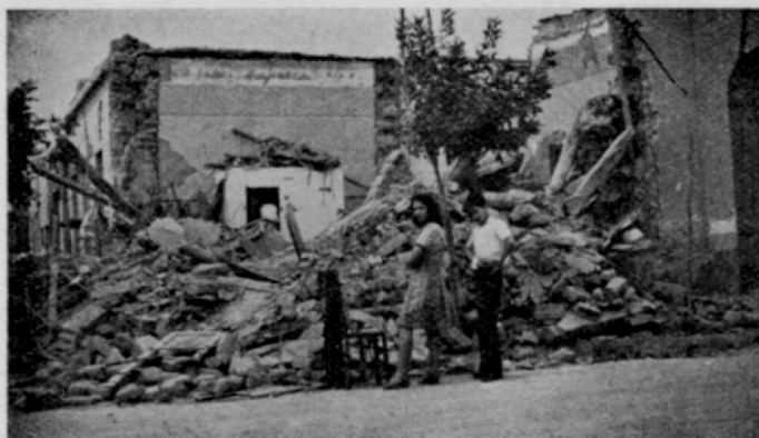
Fig. 38. — Casa de adobe destruída. Zona sud de la ciudad de San Juan. Enero 16. (Fotografía Ronchiotto)
