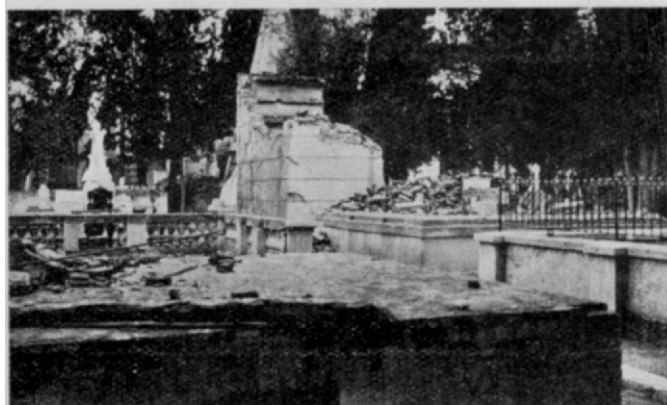
Fig. 82. — Cementerio de San Juan. Vista de panteones derruidos por el sismo. (Fotografía Castellanos)
