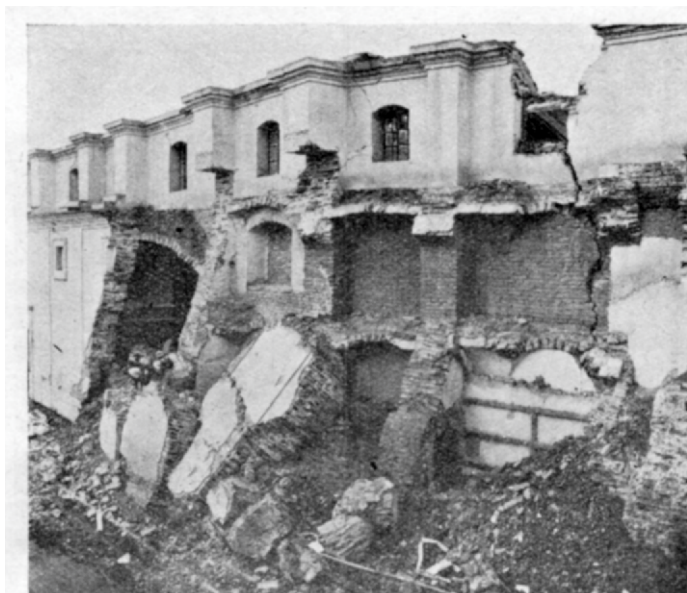
Fig. 71. — La Catedral, sobre la calle Rivadavia (corre de E. a W. y mira al N.). Se notan grietas verticales y otras de inclinación de 45^\circ que parten de los ángulos de puertas y ventanas. Se ha derrumbado la sección posterior de las naves laterales donde está el sepulcro de los obispos. (Fotografía Castellanos)
