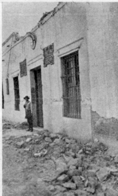
Fig. 64. — Casa donde nació Sarmiento. Cornisa en parte derribada. Frente con grietas. Calle Sarmiento. (Fotografía Castellanos)
