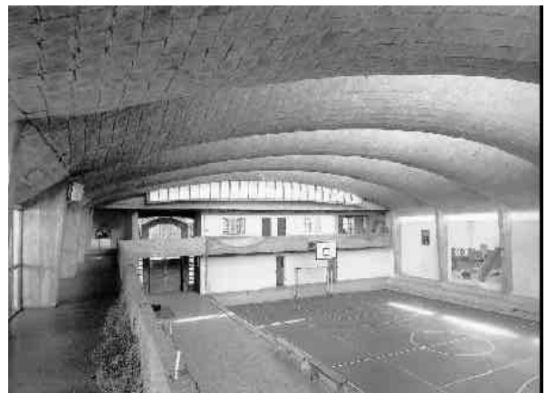
Vista interior de la cubierta
