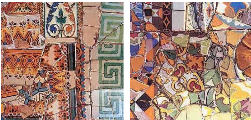
Gaudí. Parc Güell, Barcelona, 1900-1914. Dos detalles de los revestimientos en mayólica de los bancos.
