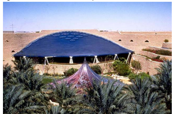
Fig. 2- Interior del Palacio.
