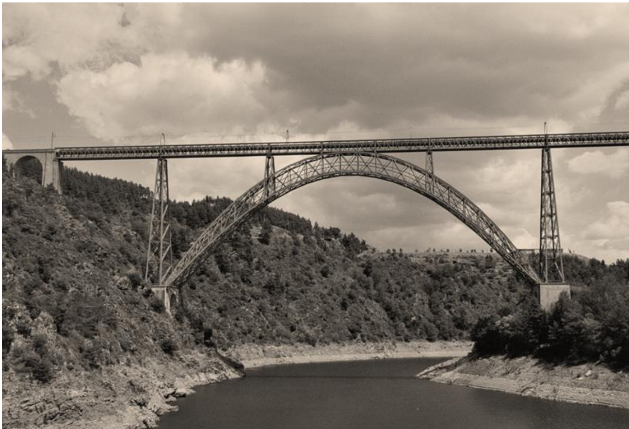
Viaduc de Garabit, 1884
