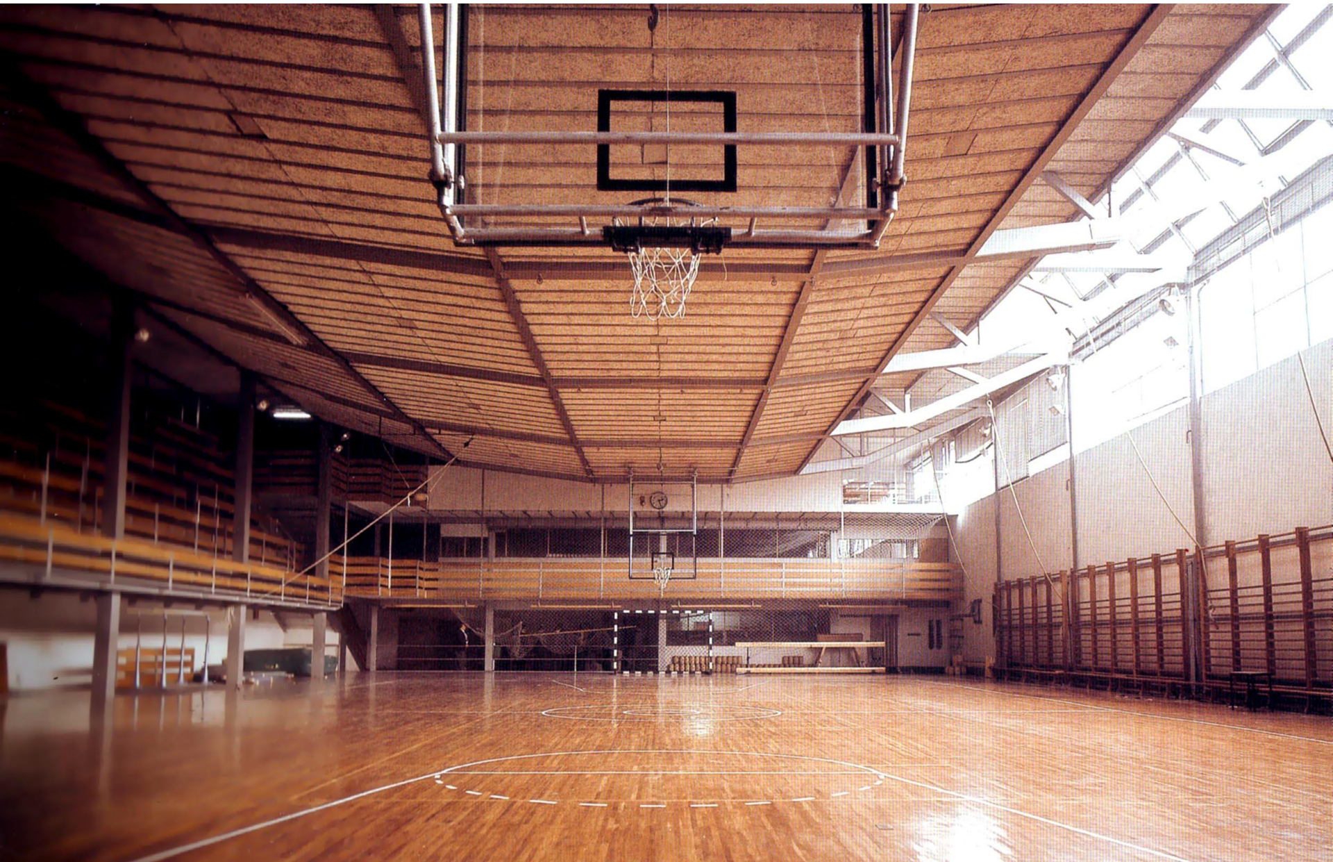
Alejandro de la Sota. Gimnasio del Colegio Maravillas. Madrid. 1960-1962
