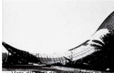
Vista del perfil de la obra, desde la azotea de una casa vecina.
