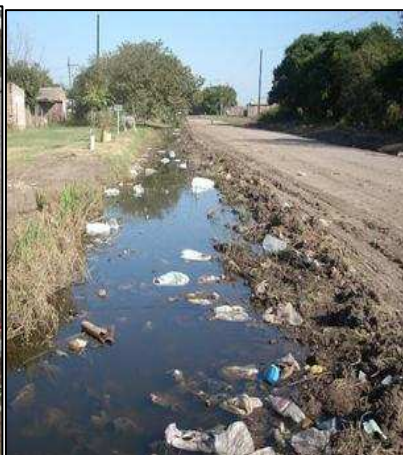
Figura 5. Zanjas obstruidas.
