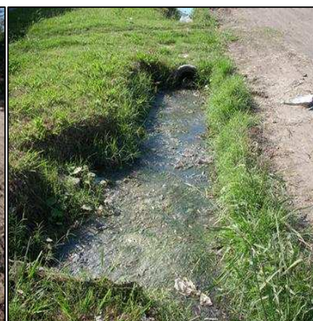
Figura 6. Contaminación en zanjas.
