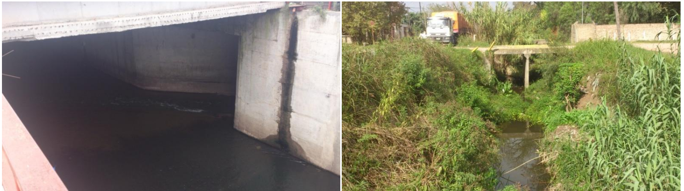
Figuras 21a y b: Desembocadura del emisario principal al arroyo Ludueña (izq). Canal Camino de los Muertos (der).
