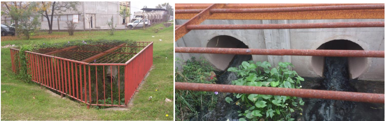
Figuras 19a y b: Embocadura del sistema de desagüe pluvial de Av. De Circunvalación sobre conducto principal del emisario.
