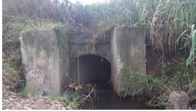
Figura 5: Entubación del conducto principal. Calles Mendoza y Furlong.
