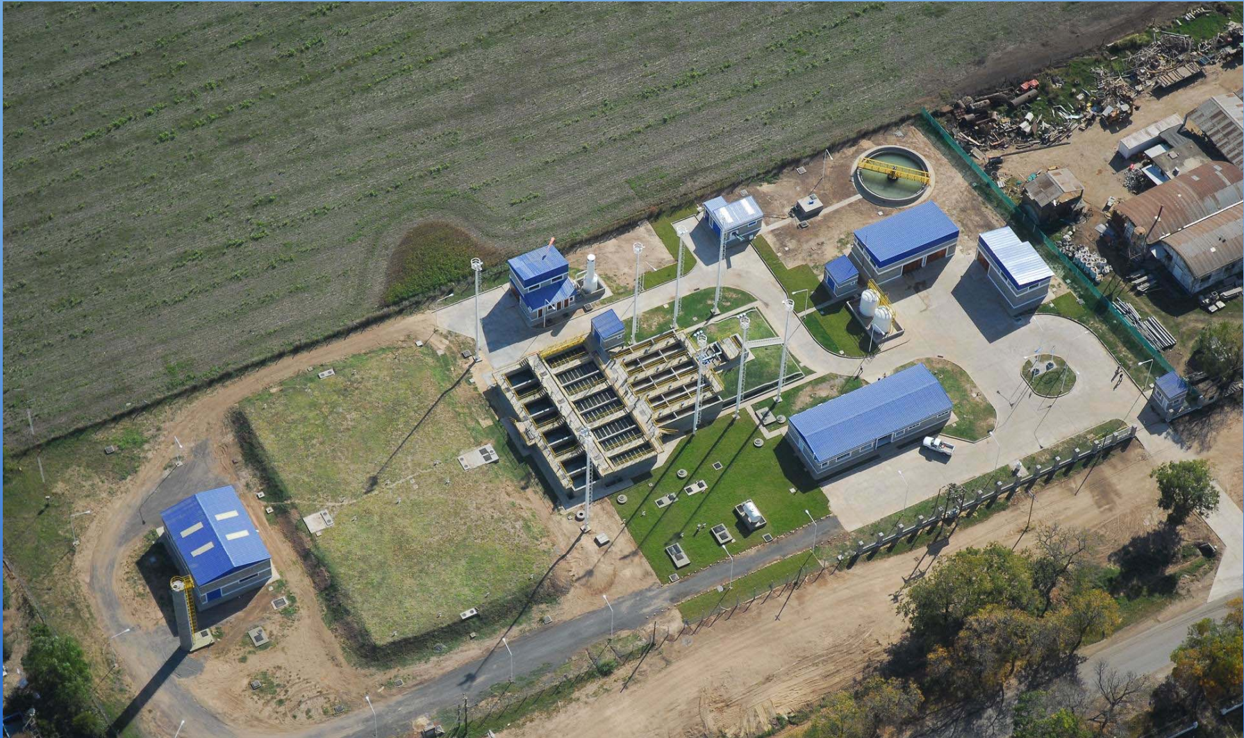
ACUEDUCTO CENTRO - Vista Planta de Tratamiento Monje
