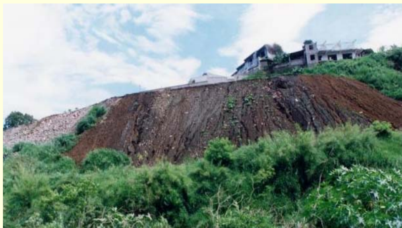
Foto 3: Deslizamiento producido por la saturación del suelo. Además puede observarse la inclinación de los árboles respecto de la vertical, lo que hace pensar que se está ante la presencia de creep.
