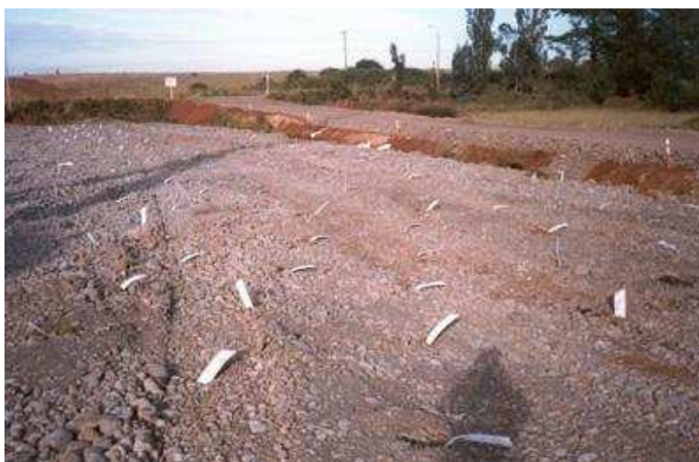
Figura 34 Ejemplo aplicación de pozos drenantes con cintas de geosintéticos
