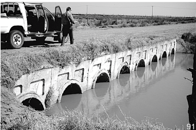
Ap. 1: 31. Estación 22 ( 34^{\circ}10'56''.5S , 61^{\circ}50'51''.3W ). Laguna Morgan. Foto 91: Alcantarilla de 8 tubos sobre el camino, conectando el canal anterior. Foto 92: Camino hacia colonia Morgan (camino y alambrados ondulados, vista hacia el W).
