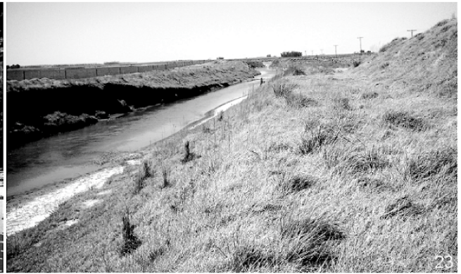
Ap. 1: 6. Estación 04 ( 34^{\circ}11'34'' .8S, 61^{\circ}59'22'' .5W). Canal Alternativa Norte sobre camino de tierra. Foto 22: Alcantarilla de 7 tubos con problemas de escurrimiento rápido y erosión. Foto 23: Canal recto aguas abajo de la alcantarilla de 7 tubos; otra alcantarilla similar al fondo.
