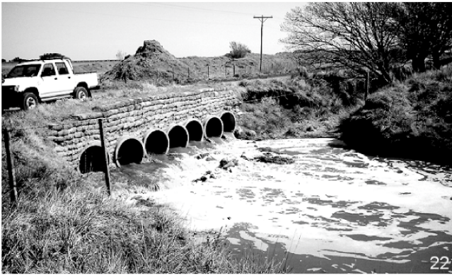
Ap. 1: 6. Estación 04 ( 34^{\circ}11'34'' .8S, 61^{\circ}59'22'' .5W). Canal Alternativa Norte sobre camino de tierra. Foto 22: Alcantarilla de 7 tubos con problemas de escurrimiento rápido y erosión. Foto 23: Canal recto aguas abajo de la alcantarilla de 7 tubos; otra alcantarilla similar al fondo.
