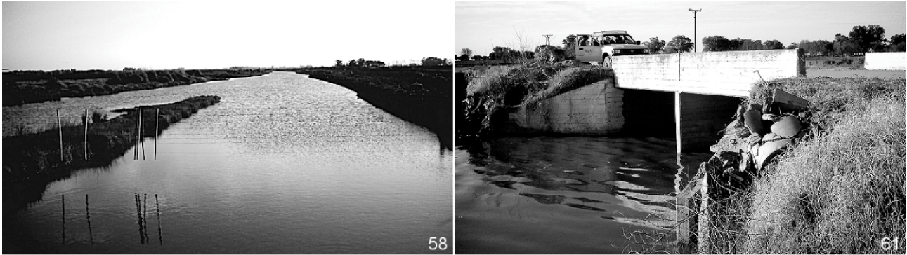
Ap. 1: 19. Estación 12 ( 34^{\circ}12'11'' .9S, 61^{\circ}32'06'' .0W). Desembocadura Canal Alternativa Norte en la laguna Del Chañar. Foto 58: Vista del canal hacia el oeste. Foto 61: Alcantarilla en el camino.
