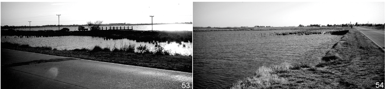
Ap. 1: 17. Estación 11 (34°10'13".9S, 61°30'01".7W). Laguna Del Chañar vista desde la Ruta 94. Foto 53: Vista de la laguna al oeste; en primer plano puente alcantarilla de camino abandonado. Foto 54: En el fondo se observa la localidad de Teodolina (al SW).
