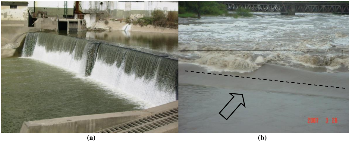
Figura 17 . Vertedero en río Carcarañá. (a) Aguas bajas 10/05/2008; (b) Crecida del 28/03/2007
